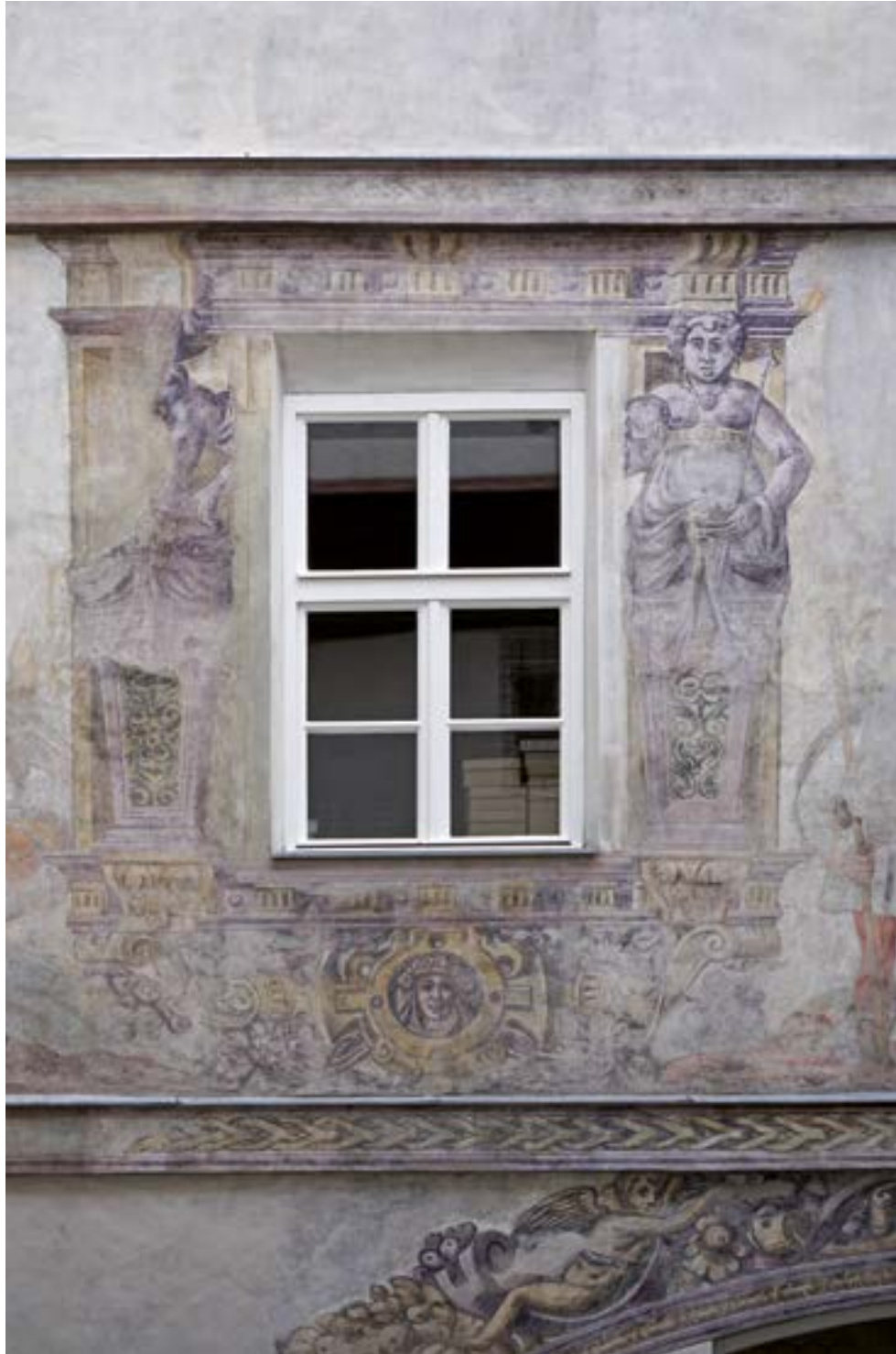
Damenstift, Innenhof, Detail Südwand nach Restaurierung
