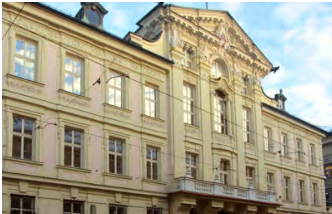
Innsbruck, Maria-Theresien-Straße 43, Landhausfassade © BDA / Hauser
