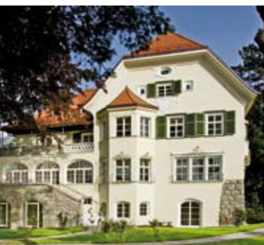
Innsbruck, Villa Steyrer, © Die Fotografen, Innsbruck
