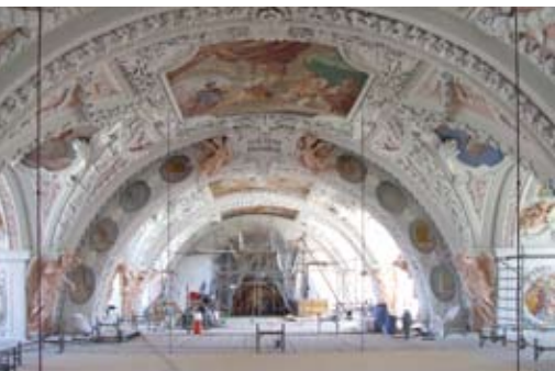
Garsten, ehem. Stiftskirche, Gewölbe während Restaurierung, © B. Heindl
