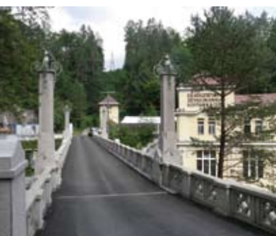
Molln, Kraftwerk Steyrdurchbruch, © B. Gasché
