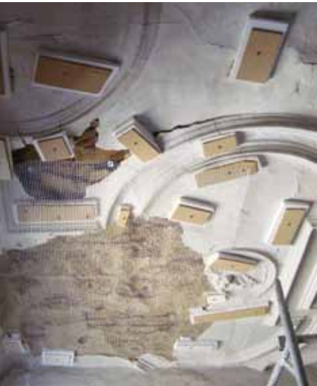
Oben: Stuckrestaurierung, Seminar Rekonstruktion und Konsolidierung von Lehmstuck in Schloss Juliusburg © BDA
